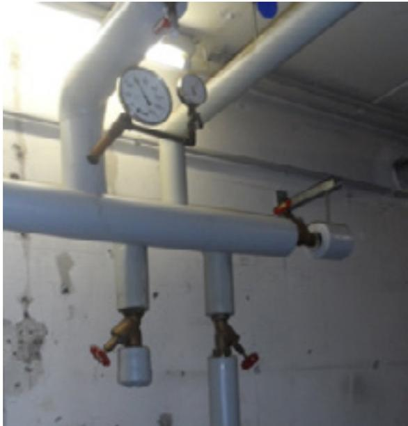
Beispiel Fehlinstallation. Das Bild aus einer Kalo-Gefährdungsanalyse zeigt, dass Leitungen nicht fachgerecht zurückgebaut wurden. So entstehen Leitungsabschnitte mit stagnierendem Wasser. Hier muss die Totleitung zurückgebaut werden
