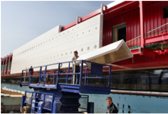
Montage Fassadenelement
