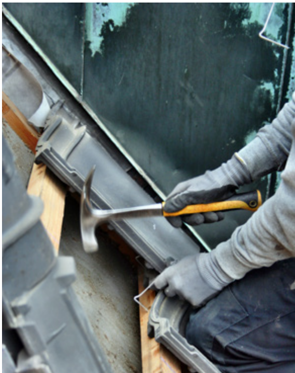
Einbau der Sturmklammer 409; Foto Krolkiewicz
