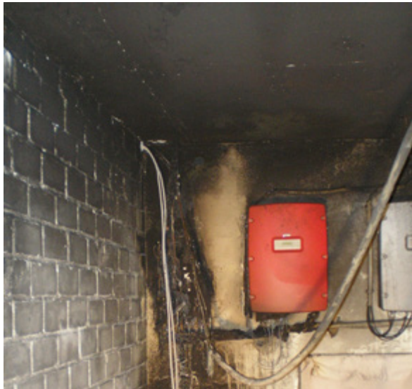
Brand an Wechselrichter; Foto VGH
