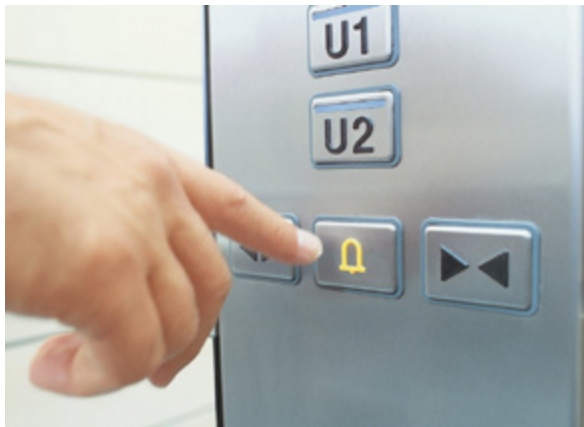
Notrufsystem; Foto Schindler
