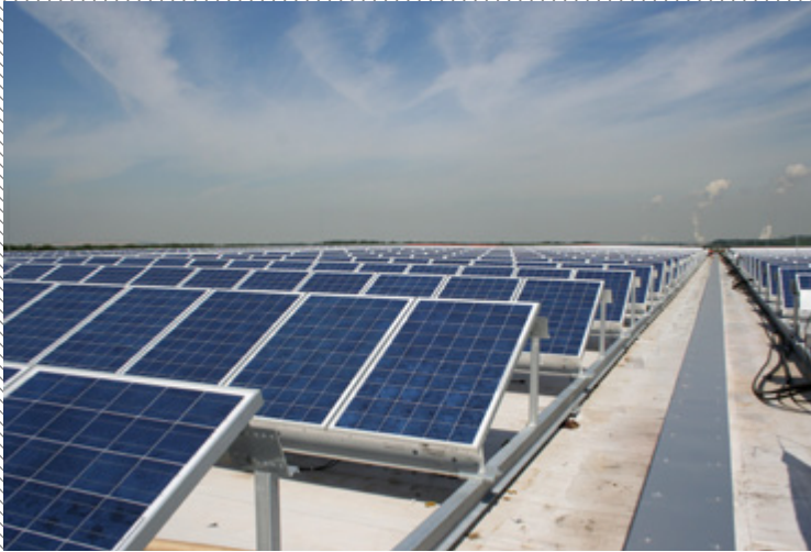
Hallendach PV-Anlage; Foto Krolkiewicz
