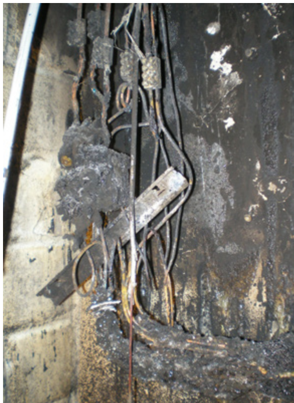
Brand an Wechselrichter; Foto VGH
