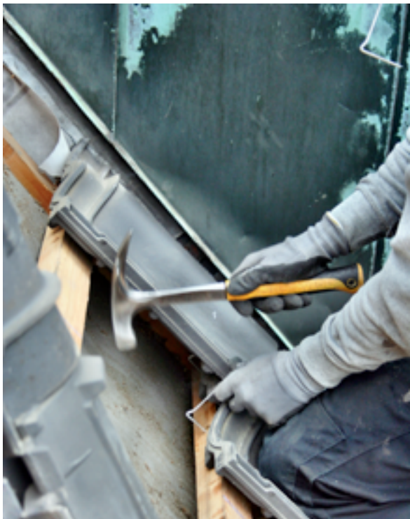
Einbau der Sturmklammer 409; Foto Krolkiewicz
