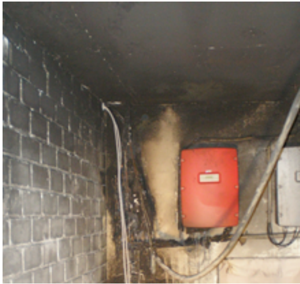
Brand an Wechselrichter; Foto VGH
