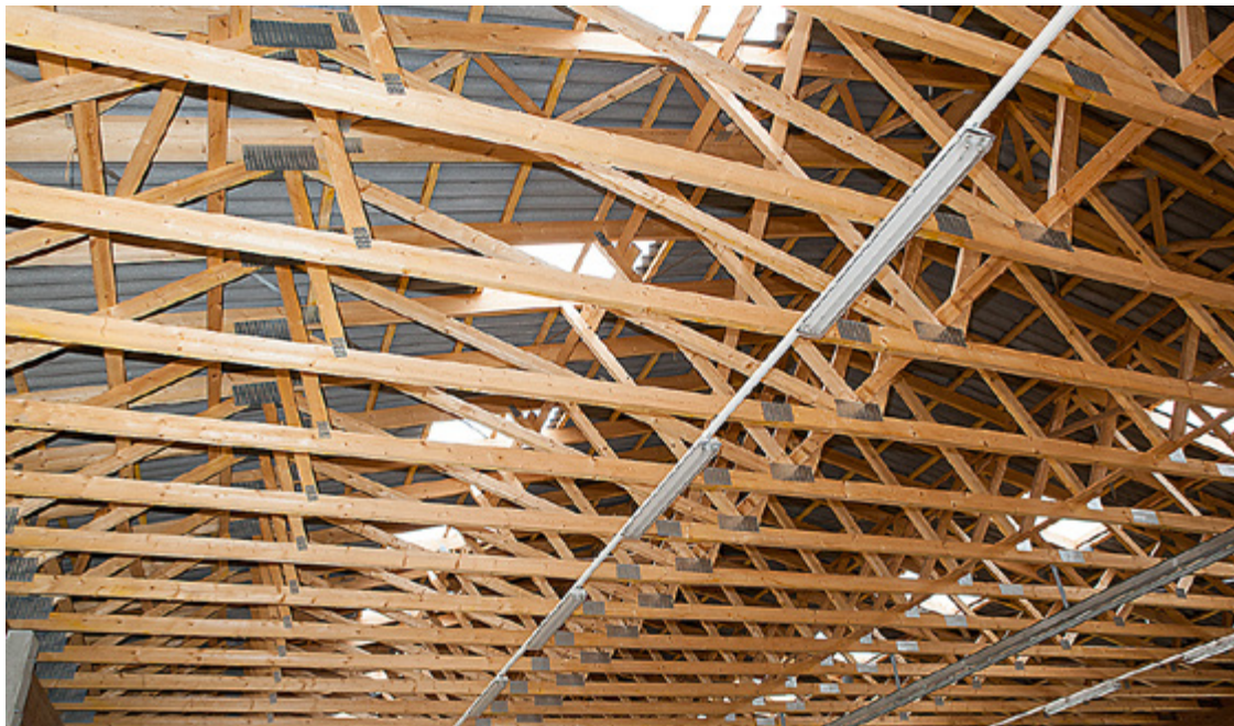
Hallendach mit Nagelbinder; alle Fotos GIN-A.Nuding
