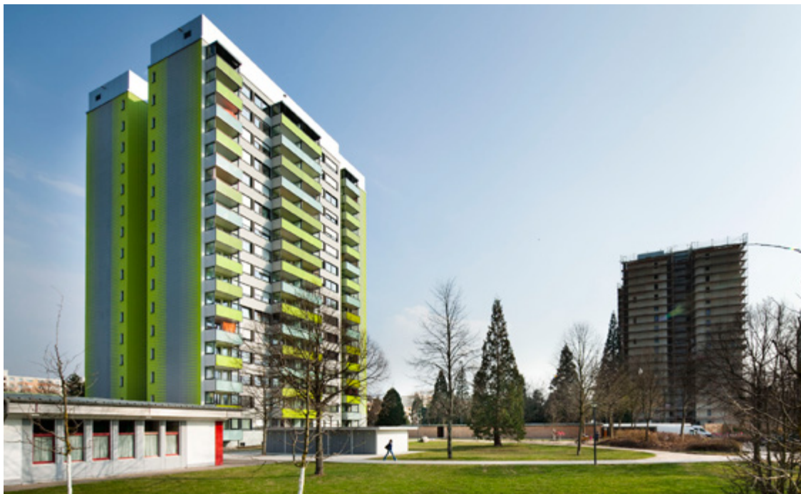
Saniertes Hochhaus; Foto Vogt Sto AG
