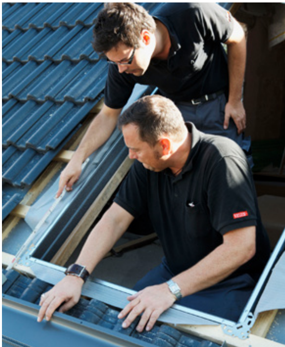
Fensteraustausch; Foto velux
