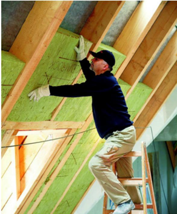
Sparrendämmung Baustoffklasse A; Foto Rockwool
