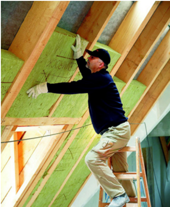
Sparrendämmung Baustoffklasse A; Foto Rockwool
