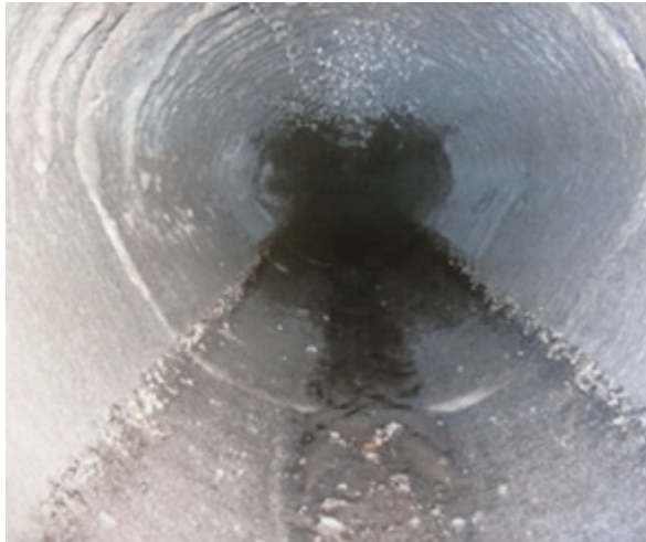
Abwasserrohr saniert
