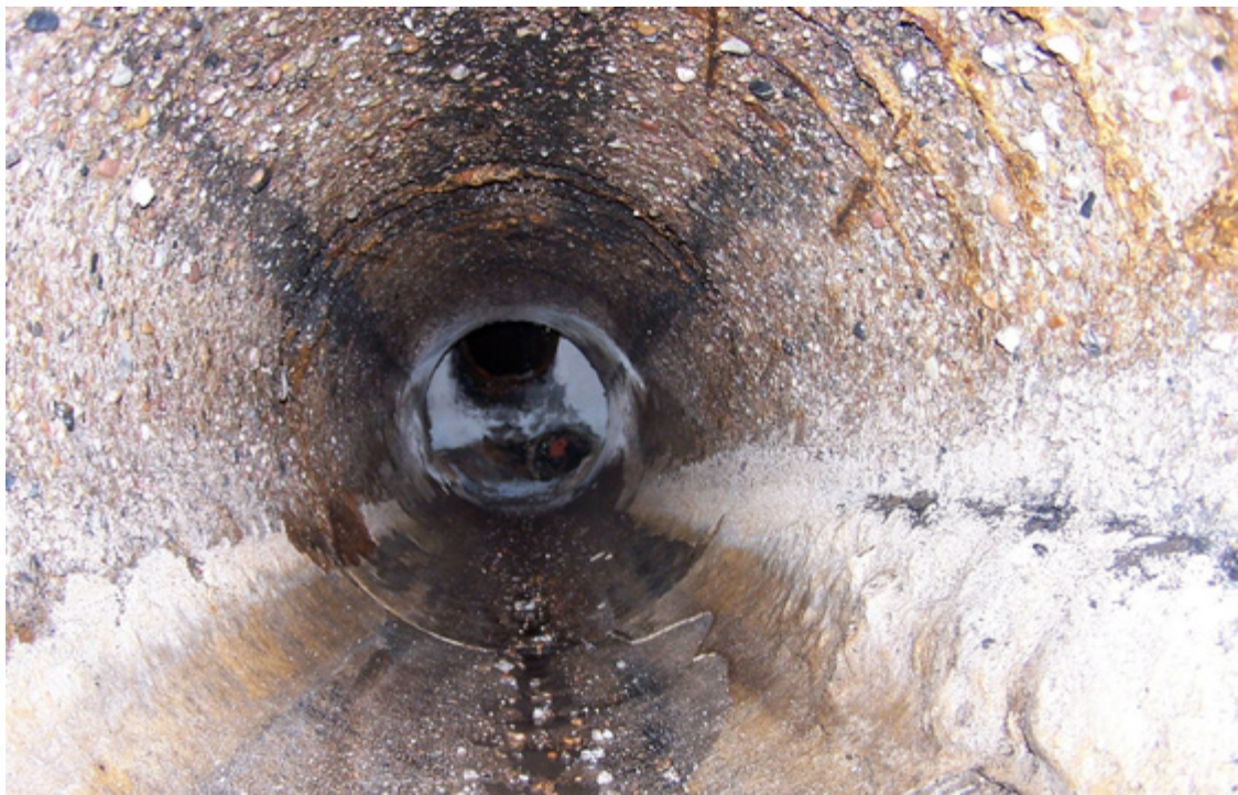
Abwasserrohr vor Sanierung; Foto Sinnotec
