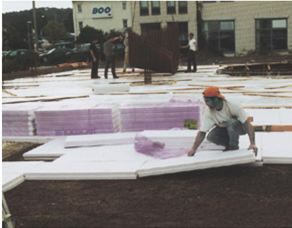
Dämmung Bodenplatte; Foto Jackodur
