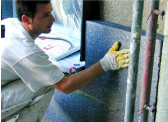
WDVS Fassadendämmung mit XPS
