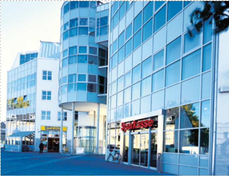
Neue Mitte Mülheim Broich - Wohnen und Arbeiten, Prinzeß-Luise-Straße/ Bülowstraße; Foto M.Ehrich/ Archiv GAGFAH
