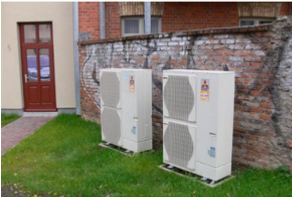
Im Innenhof entnehmen die Luft-Wasser-Wärmepumpen der Außenluft die Umweltwärme – hier das 23 kW (li.) und ein 14 kW Außengerät (re.). Fotos Becker
