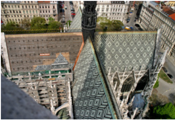
Dachsanierung Ringstrassendom Wien
