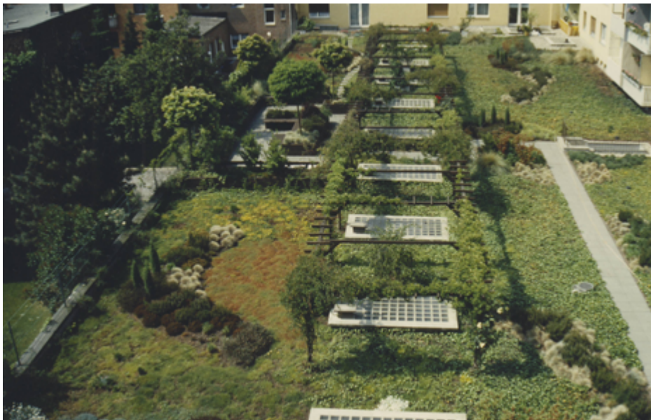
Wohnanlage Flachdachbegrünung; alle Foto optima
