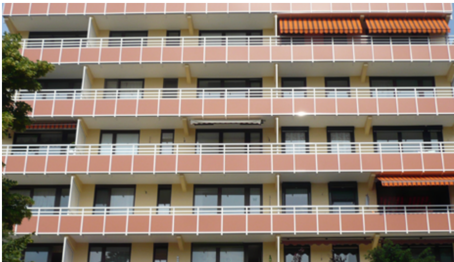
Hochhaus Ratingen; alle Foto Triflex
