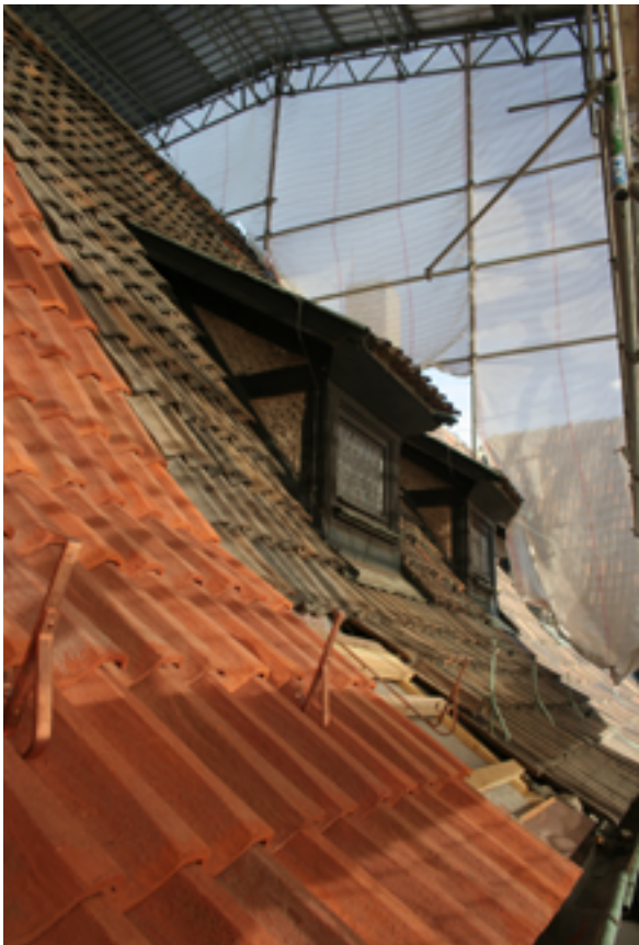
Neueindeckung mit Altdachteil
