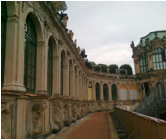
Bogengalerie K von Aussen
