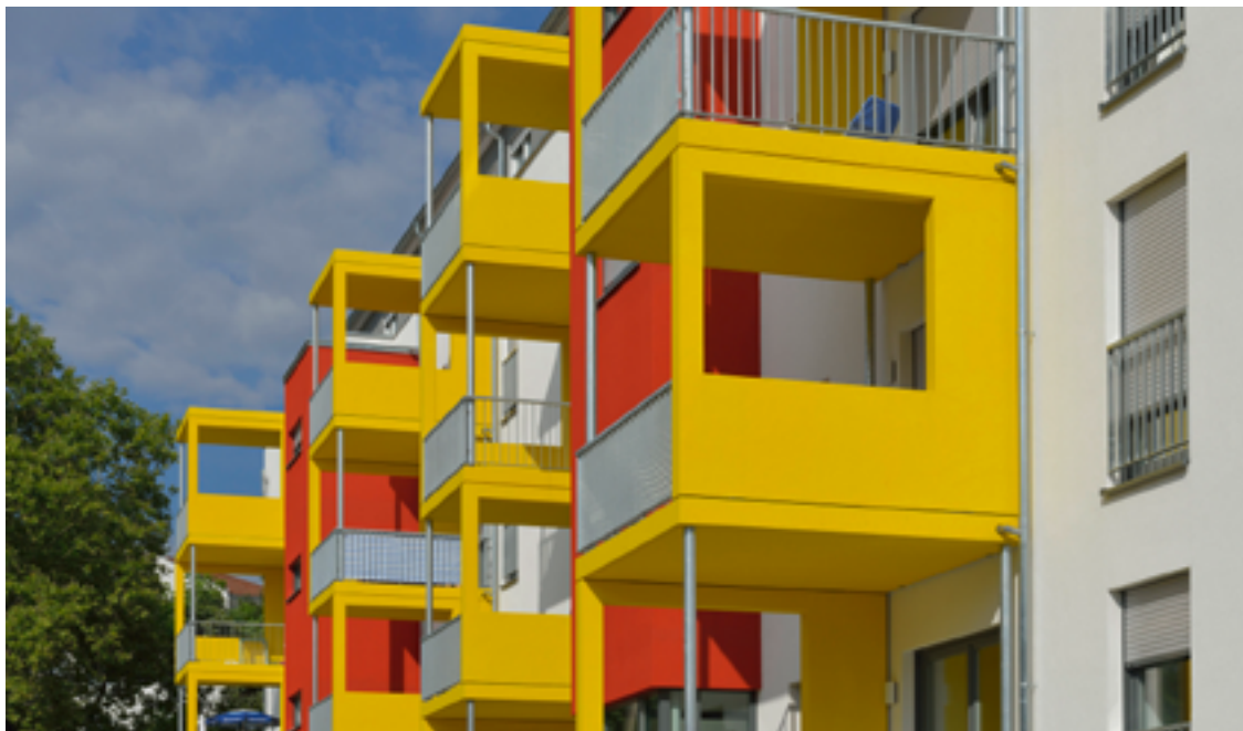
Neue Balkone; alle Fotos Schöck
