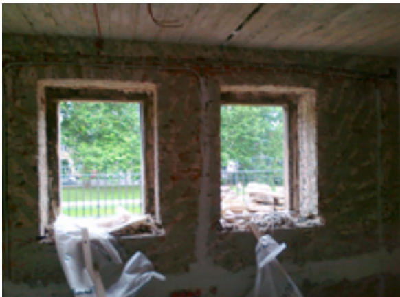
Zwinger Anbau R vor Sanierung
