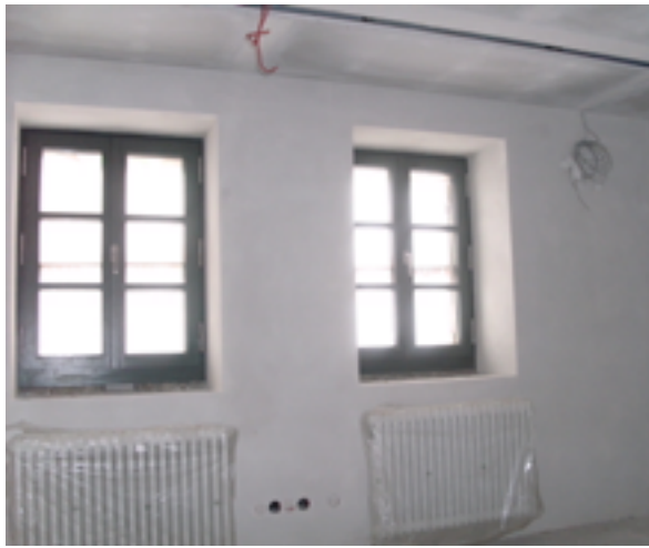
Zwinger Anbau nach Sanierung
