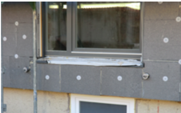
Anschluss mit WDVS
