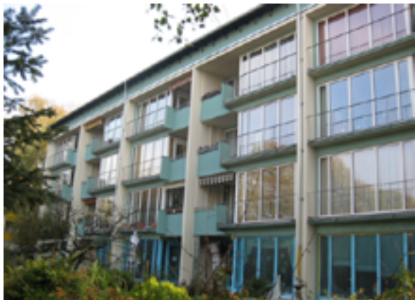
Frisch saniertes Wohnhaus Cautiusstraße/Michelstadter Weg
