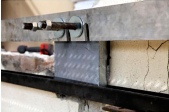
Das Anschlusselement, das die Balkonplatte mit der Altbausubstanz verbindet, wurde von den Ingenieuren der Schöck Balkon-systeme entwickelt. Es enthält die bewährte Schöck Isokorb Technologie und sorgt damit für eine thermische Trennung der Balkone vom Gebäude. Das Bauteil gewährleistet durch seine Dämmfuge und die Verwendung von Edelstahl eine hervorragende Wärmedäm-
