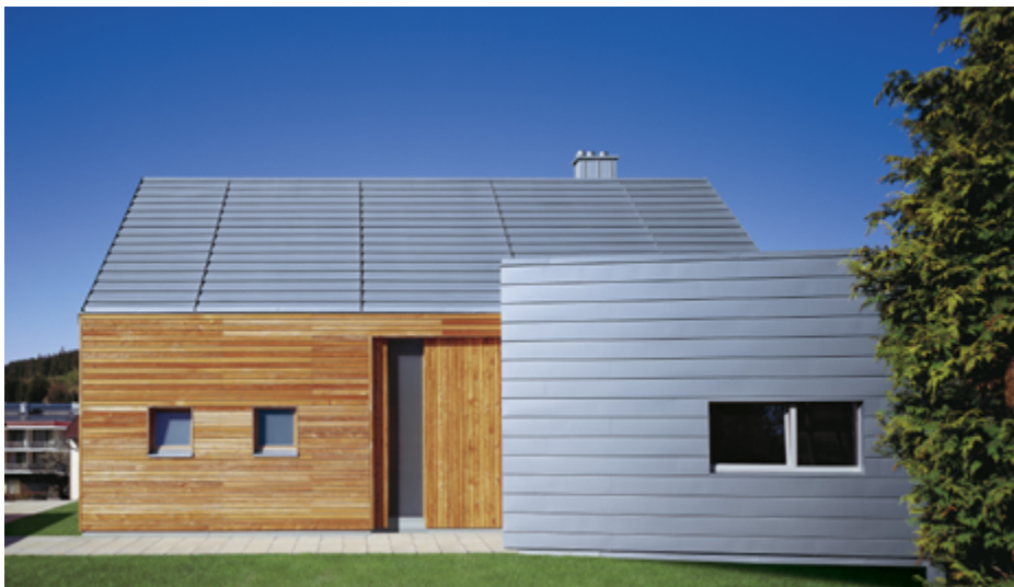
Fassade Steckfalspaneel Wohnhaus in Österreich; Foto Rheinzink
