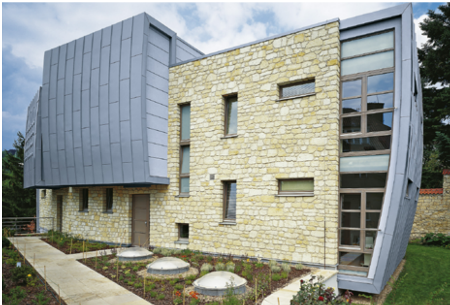
Fassade Winkelstehfalzpaneel Wohnhaus Prag; Foto Rhe- inzink
