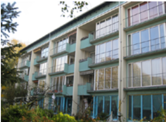
Frisch saniertes Wohnhaus Cautiusstraße/Michelstadter Weg
