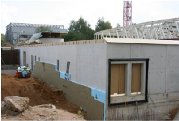
Die DIN V 4108-4 beschreibt, wie bei Dämmstoffen für den Hochbau nach den harmonisierten europäischen Normen DIN EN 13162 bis DIN EN 13171 der Bemessungswert der Wärmeleitfähigkeit für die Anwendung in Deutschland festgelegt wird. Dieser Hinweis ist wichtig, wenn man Dämmstoffe ausländischer Produktion in Deutschland verarbeiten möchte. Das trifft auf alle
