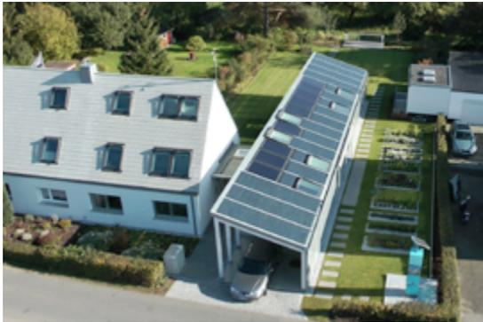
teten Räumen kann auch an trüben Tagen meist auf künstliche Beleuchtung verzichtet werden. Ein neu errichteter Anbau bietet zusätzliche Wohnfläche und steht darüber hinaus im Mittelpunkt des innovativen Energiekonzeptes: Die auf dem Dach des Anbaus installierten Photovoltaik-Module und Solarthermie-Kollektoren erzeugen in Kombination mit einer Luft-Wasser-Wärmepumpe die im
