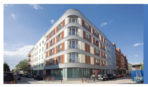
Neue Attraktivität erlangte das Mehrfamilienhaus aus den 50er Jahren nach einer umfassenden und energetischen Sanierung. Zur positiven Energiebilanz trägt ein Wasser/Wasser-Wärmepumpen-System von STIEBEL ELTRON bei.
