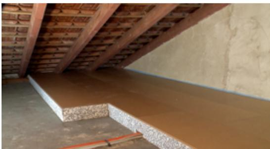
Bei Speicherdämmplatten muss der Untergrund plan, sauber, trocken und fest sein. Etwaige Unebenheiten müssen zum Beispiel mit Trockenschüttungen vorher ausgeglichen werden. Die CapaClick®-Speicherdämmelemente werden mit der Feder nach vorne im Verband verlegt und press aneinander gestoßen. Durch den Stufenfalz
