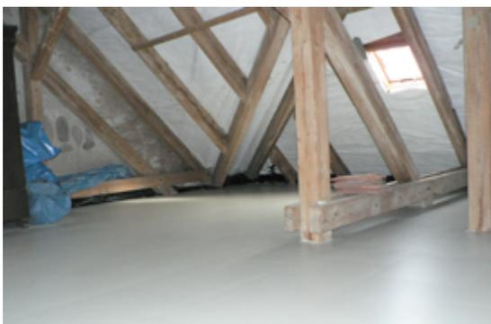
Zum Dämmen der obersten begehbaren Geschossdecke werden in Deutschland zahlreiche Produkte angeboten. So sind die am Markt befindlichen Dämmplatten mit verschiedenen Werkstoffen wie Span-, OSB- oder Gipsfaserplatten kaschiert. Die Dicken der Plattenwerkstoffe variieren zwischen zehn und 19 Millimeter. Die Kanten der Plattenbeläge sind oftmals stumpf, besitzen aber bei 19
