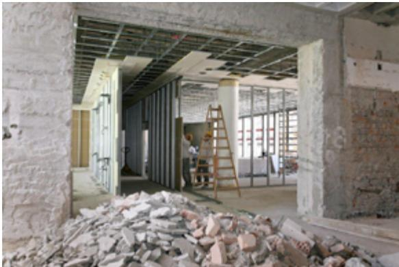
Das neue Wohngebäude ist eine gelungene Mischung aus Alt und Neu geworden: Fassade, Säulenportal, Foyer und historisches Treppenhaus wurden behutsam wieder aufgearbeitet. Der Rest des Baukörpers wurde bis auf Stützen und Decken weitgehend entkernt und sukzessive wieder aufgebaut. Die Decken wurden mit Trockenbau ertüchtigt. Wände und Vorsatzschalen etwa vor
