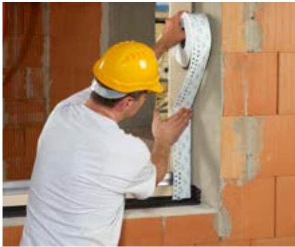
Dichtband; Foto Siga
