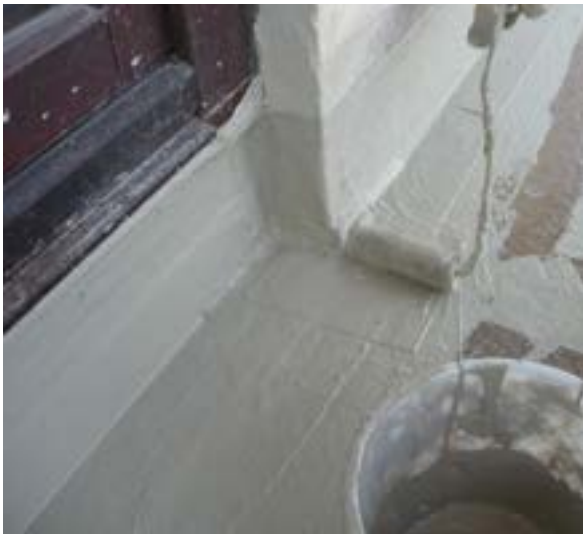
Beschichtung der Türanschlüsse
