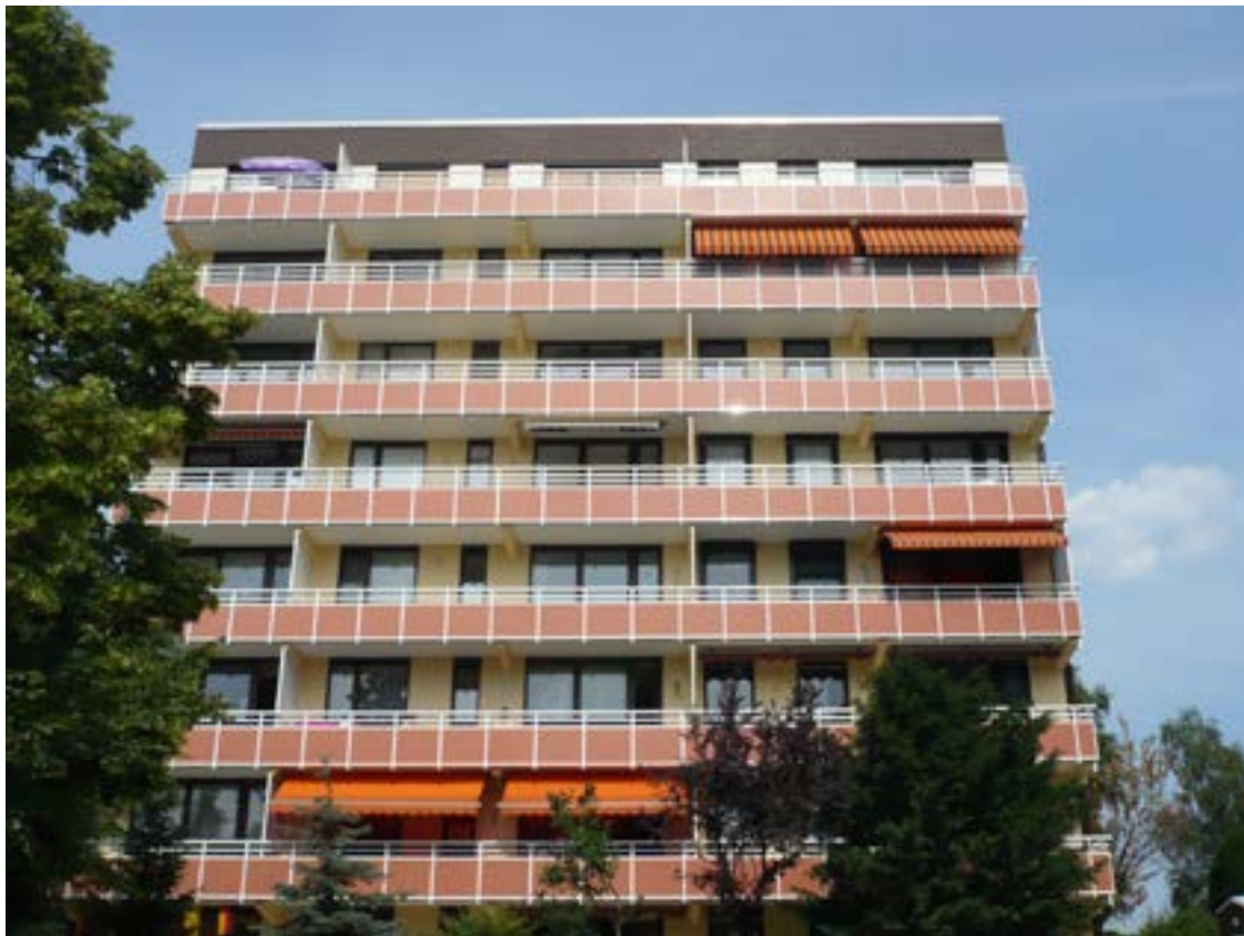
Ansicht Balkone Hochhaus; alle Fotos Triflex
