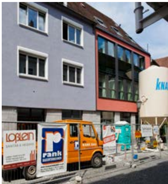
Baustelle; alle Fotos Knauf
