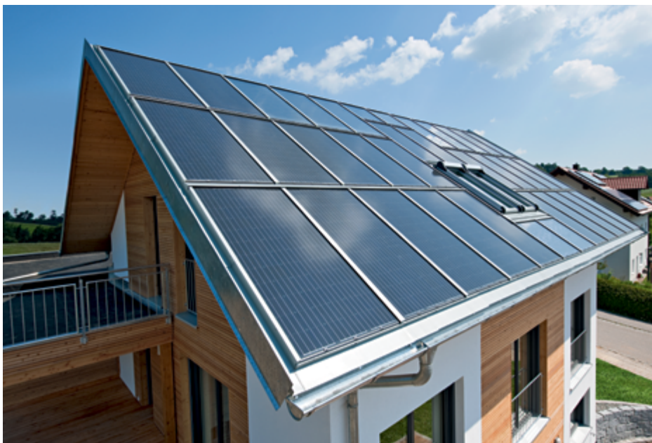
Dachintegriertes Solarsystem: alle Fotos Roto
