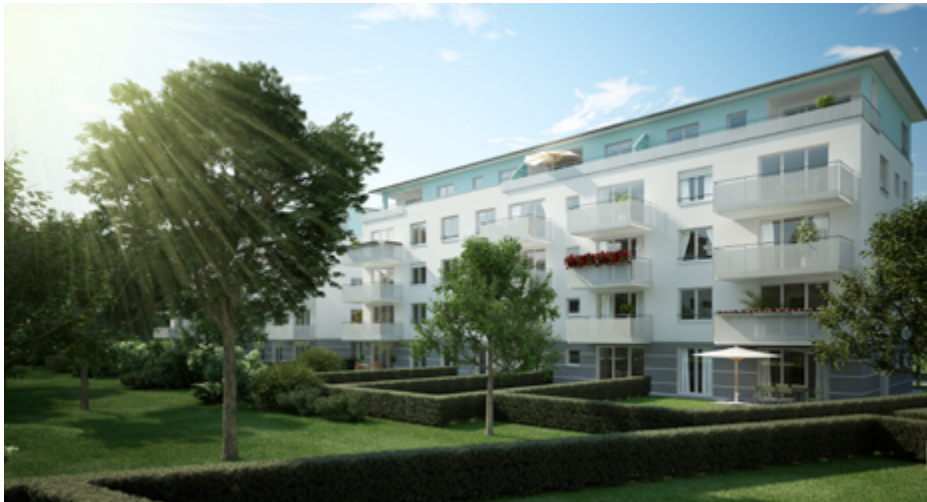
Innenhof mit Grünanlage; Foto RIB
