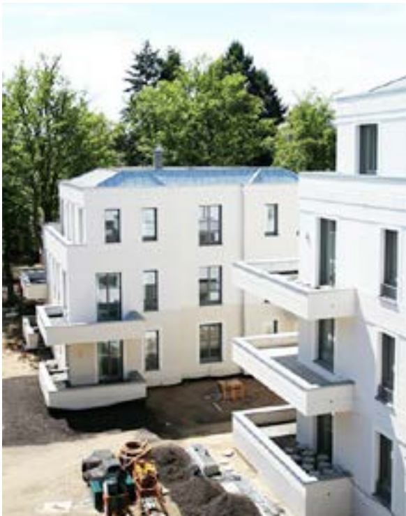
während der Bauarbeiten
