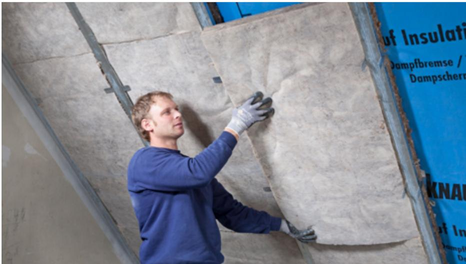
Die Installationsebene wurde mit 60 mm dicker Knauf Insulation Untersparren-Dämmrolle TI 432 U (WLG 032) ausgefüllt.
