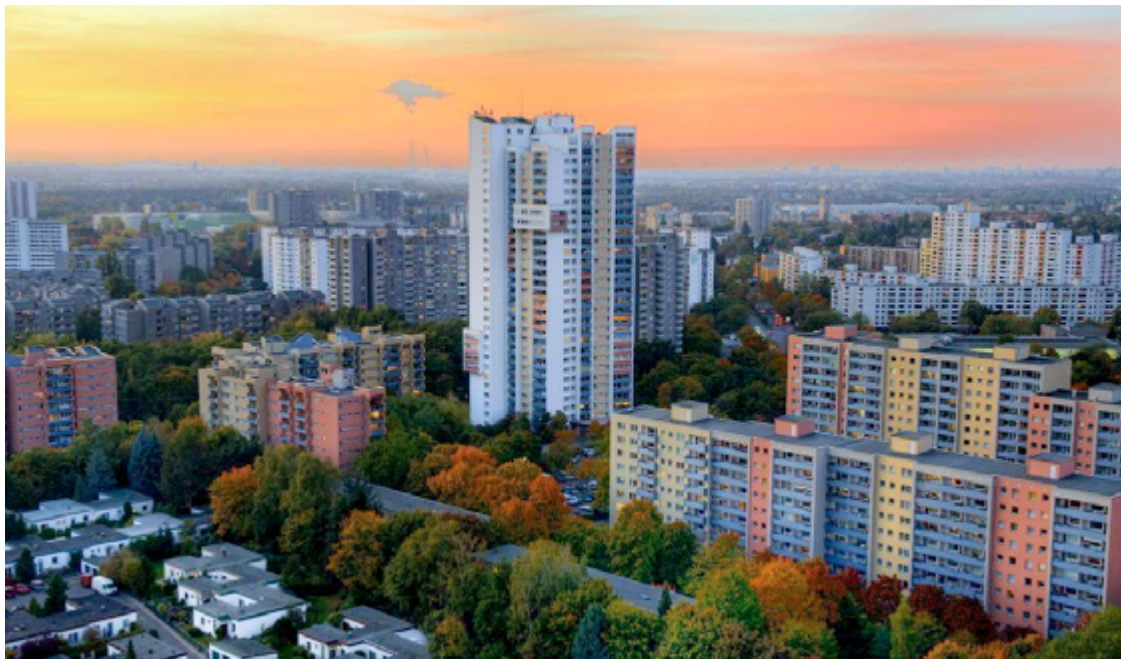
Die Berliner Gropiusstadt saniert
