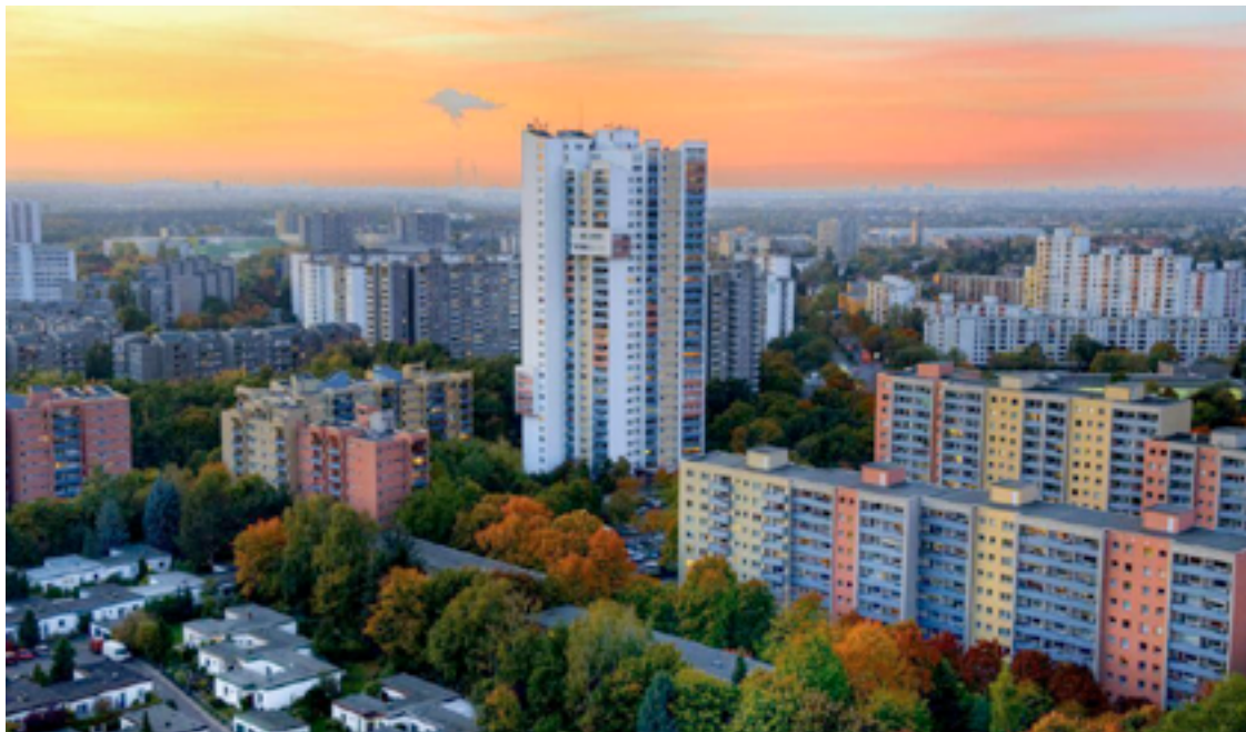
Die Berliner Gropiusstadt saniert
