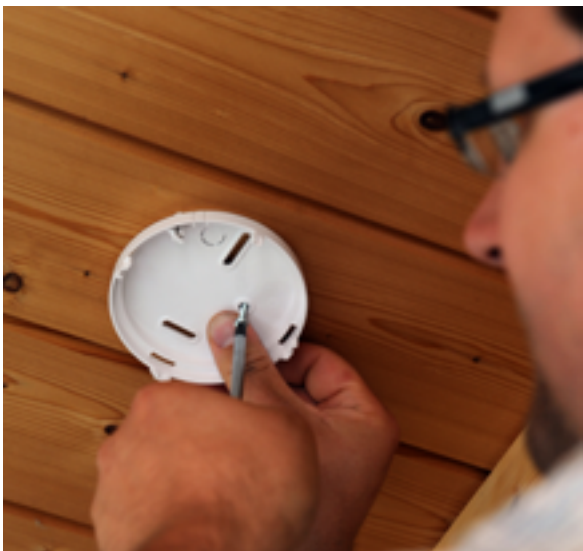
Schnell, sauber, lärmfrei – Klebmontage eines Rauchwarnmelder
