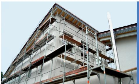
Holzfaserdämmung Fassade; Foto VDH
