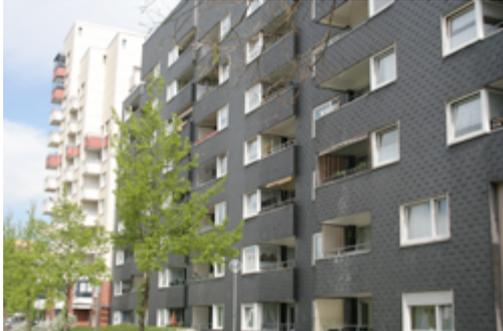
Bei der hinterlüfteten Fassade handelt es sich um ein mehrschichtige Konstruktion, die bei fachgerechter Ausführung eine langlebige Funktion gewährleistet. Die konsequente Trennung der Wetterhaut von Wärmedämmung und Tragwerk schützt das Gebäude vor Witterungseinflüssen. Tragende Außenwände und die Dämmung bleiben trocken und daher voll funktionsfähig. Selbst durch offene Fugen eindringen-
