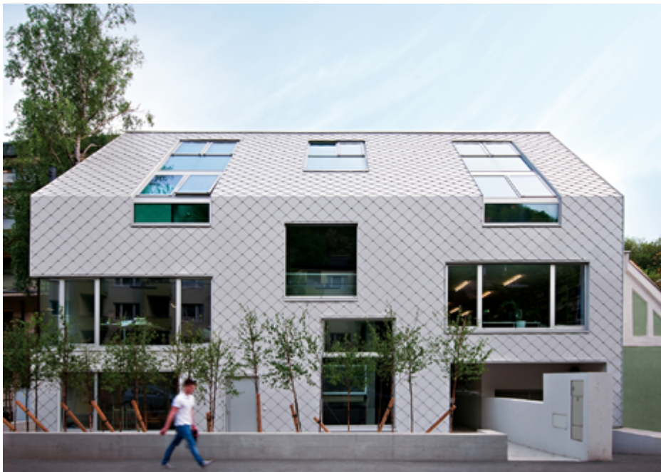
Strassenansicht: Foto Prefa
