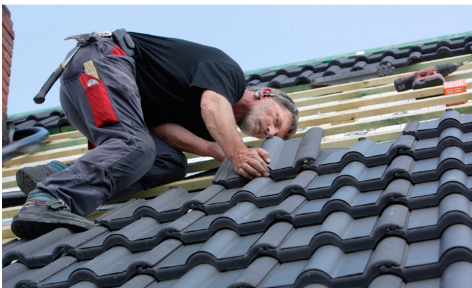
Verlegung Dachziegel; Foto Nelskamp
