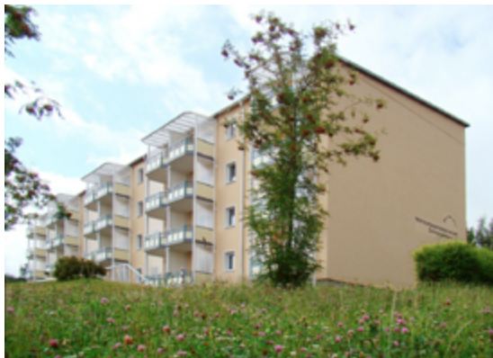
Moderner Haustechnik im Gebäude „Wiesengrund 2-8“ der Wohnungsgenossenschaft Schwarzenberg eG; alle Fotos WG Schwarzenberg
