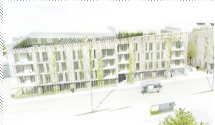
Freiburger Quartier „Vauban“; Foto FSB
