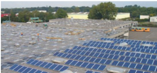
Die Dachabdichtung ist nach Aufbringen der Photovoltaikanlage zum großen Teil nicht mehr einsehbar. Die Ortung von Leckagen ist dann ohne die Deinstallation der Photovoltaikanlage nahezu unmöglich, es sei denn ein Leckmeldesystem ist in das Dach integriert.
