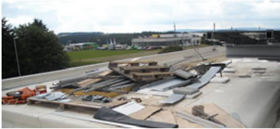
Eine typische Situation auf einem Flachdach während der Errichtung einer Photovoltaikanlage. Beschädigungen der Dachhaut sind hier sehr wahrscheinlich.
