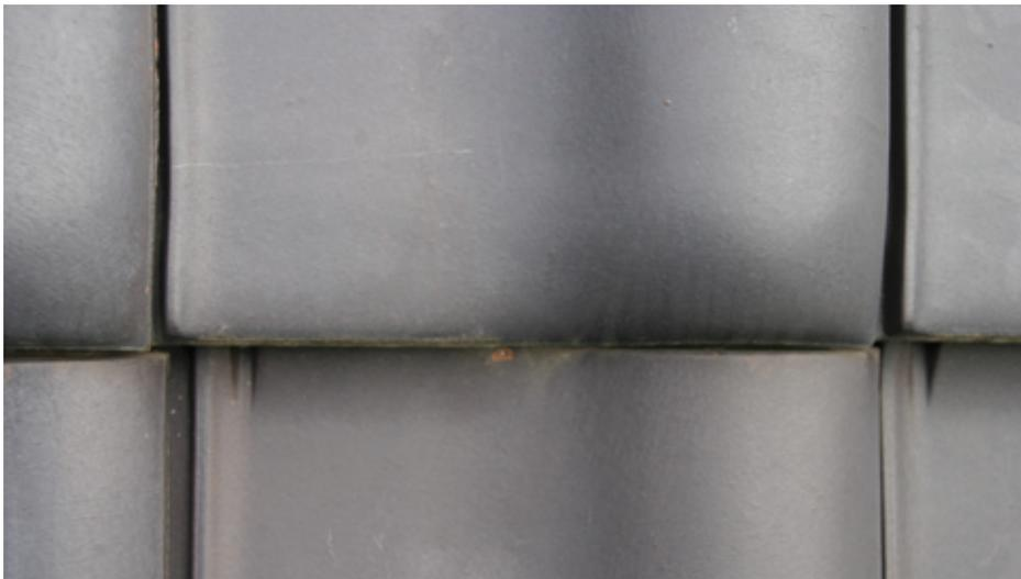
Absprengung durch Fremdpartikel an Tondachziegel
