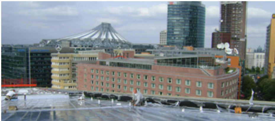
Die Staatsbibliothek Berlin mit der Metaldacheindeckung. Im Hintergrund die Gebäude des Potsdamer Platzes
