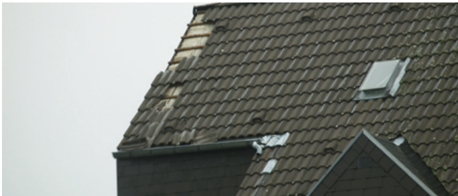
Luftwirbel greifen unter die Dachziegel, Fotos privat
