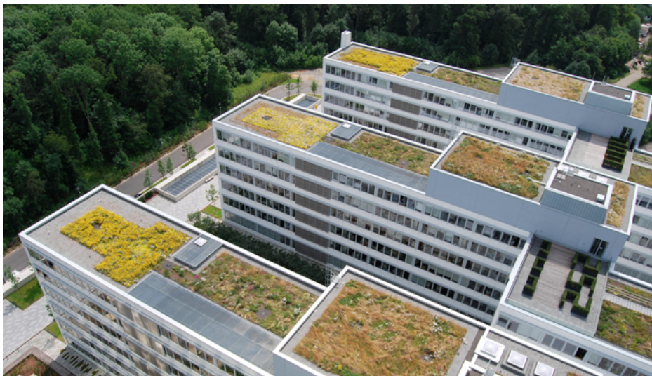
Begrüntes Flachdach: Foto FBB
