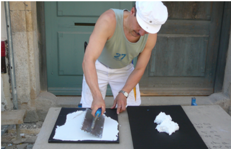
Verarbeitung einer Dämmplatte; Foto va-Q-tec
