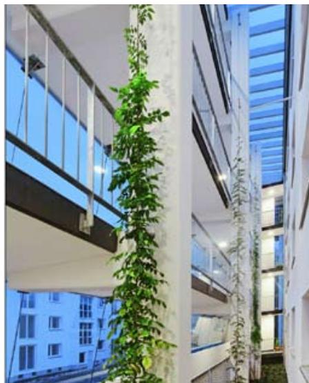
Ein verglaster Laubengang wurde der Nordseite vorgestellt und ein verglastes Schachtgerüst angeschlossen. Das eckprofillose Schachtgerüst sollte architektonische Qualität und Prägnanz unterstreichen, indem die Glasplatten direkt aufeinanderstoßen. Somit wirkt der Schacht an sich transparent und luzide, aufgrund einer KONE Sonderkonstruktion auf Architektenwunsch.
