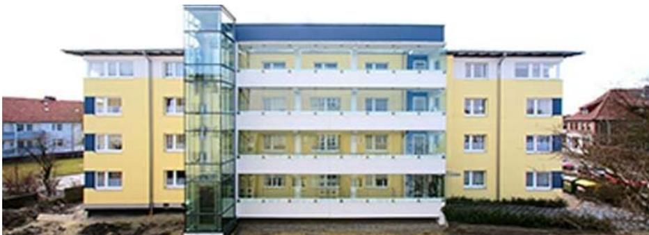
Filigran verbindet sich der Laubengang und der Fahrstuhlturm mit dem Gebäude. Jede der KONE Aufzugsanlagen hat vier Haltestellen und bedient neben dem Erdgeschoss alle Stockwerke für einen barrierefreien Zugang zu allen Wohnungen. Alle Fotos und Grafiken Kone
