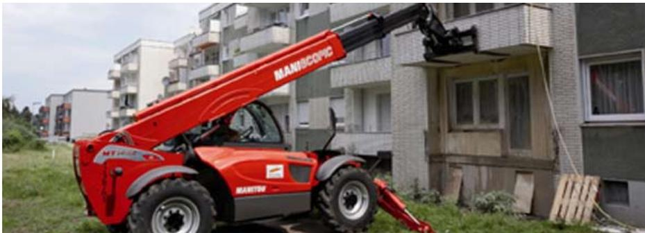
Alte Balkone werden abgeschnitten und mit einem Hubstapler abgetragen.
