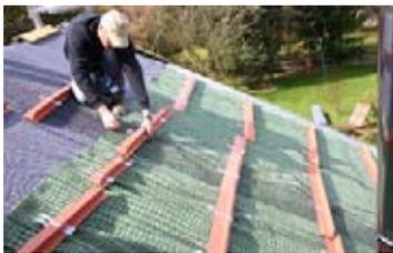
Eine Dachbegrünung übernimmt bei fachgerechter Planung und Ausführung die Schutzfunktion einer Oberlagsbahn. Hinzu kommen noch aufgrund der Substratdicke und Pflanzendichtigkeit zusätzlicher Schall- und Wärmeschutz sowie die Minderung der Sonneneinstrahlung auf die Dachkonstruktion. Damit werden die ausgeführte Dachabdichtung und Wärmedämmung geringeren physikalischen und/
