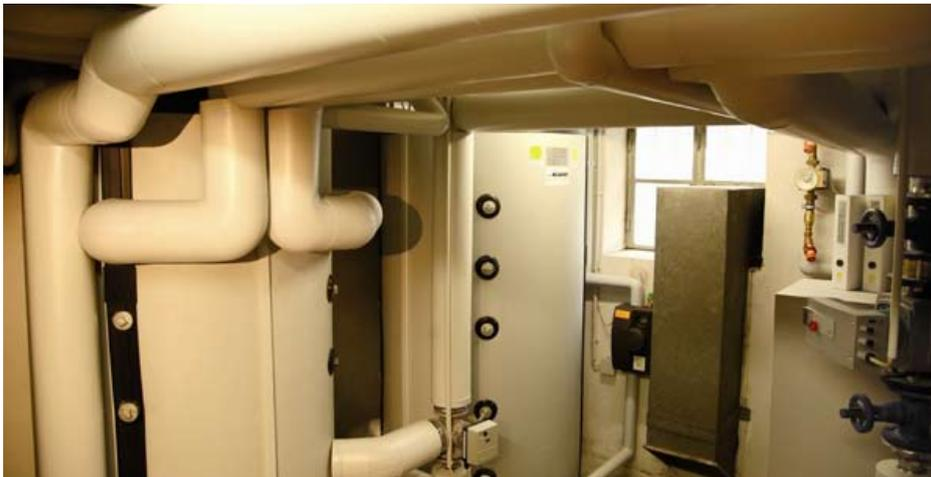
Gasbrennwert-Kaskade im Heizungsraum
