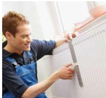
Ob Verdunsterröhrchen oder Funk gesteuerte Heizkostenverteiler, sie müssen punktgenau an Heizkörper angebracht sein.
