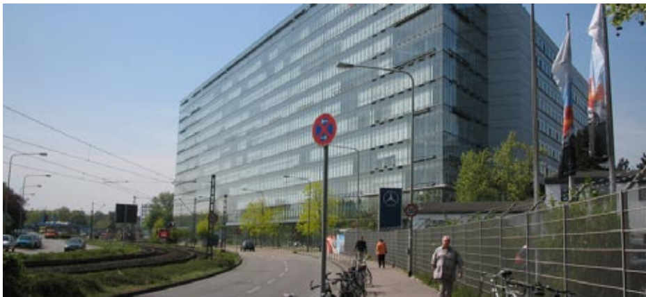
Der Sitz der Deka-Bank ist ein „Green Building“, ein Niedrigenergiehaus ganz aus Glas und Stahl.
