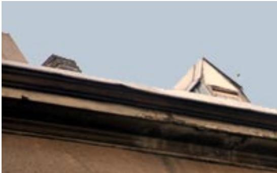
Rinnenschaden durch Überlauf und Rost, Bauschaden an der Fassade
