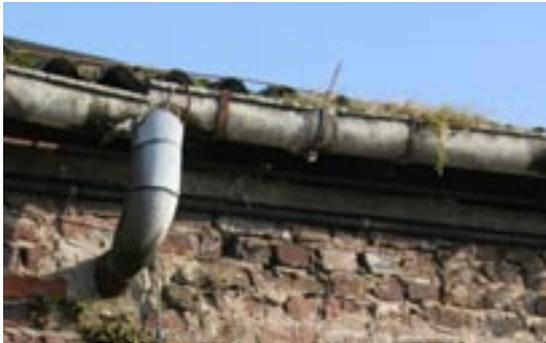
Fehlerhafte Einleitung des Fallrohres und Rinnenbeschädigung mit Bauschaden in der Fassade (Bemoosung)
