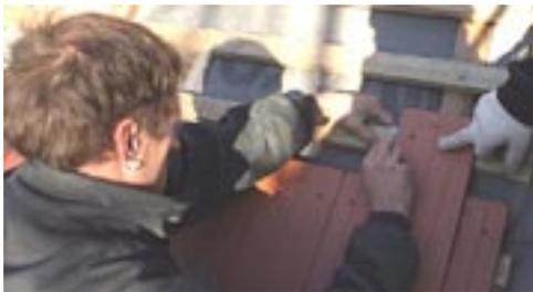
Diese zusätzlichen Maßnahmen können durch Vermörtelung als Fugenverstrich, durch Verwendung von Befestigungsmitteln oder Einsatz von Klammern erfolgen.
