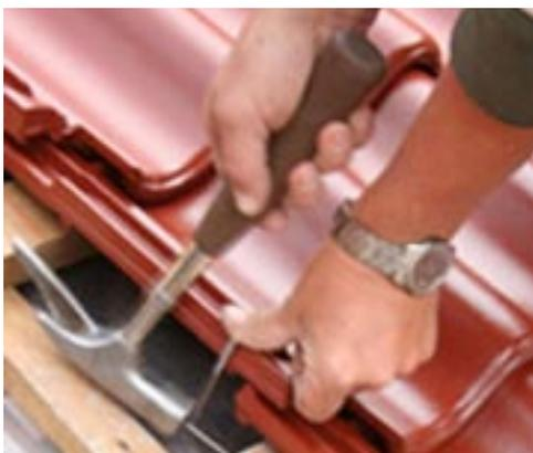
nur gering korrosionsgeschützt sind, oder aus Kostengründen billige Plagiate verwendet werden, die vom Hersteller nicht zugelassen sind. Im später möglichen Schadenfall haften Dachdecker und Bauleitung voll und die vermeintlich kostengünstige Lösung wird sehr teuer. Unmittelbar der Witterung ausgesetzte Befestigungsmittel müssen korrosionsbeständig sein. Bindedraht muss grundsätzlich auch korrosionsbeständig sein.
